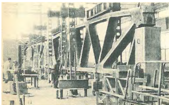
Încercarea unui ansamblu de două ferme de cîte 18 m(sus) și de 12m(dreapta) deschidere, cu continuitate pe reazemul central
